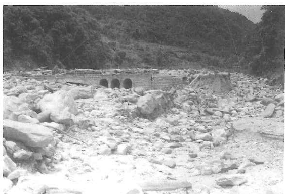
照片 2.15 培龙沟 1983 年暴发冰川泥石流,破坏川藏公路和桥梁
